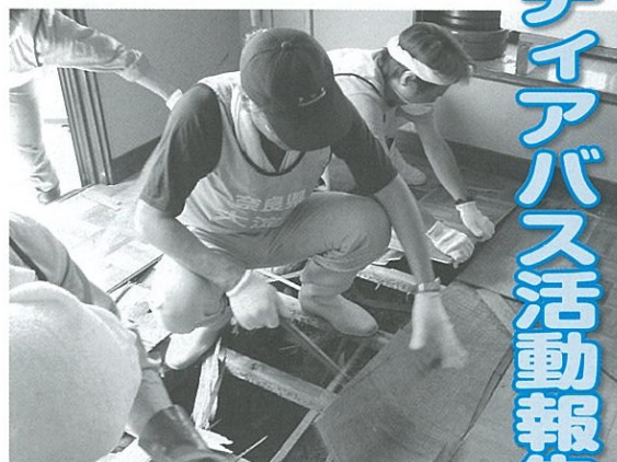
家屋の床はがし、泥出し
